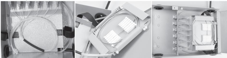
**8.1.3** Faça a fusão das fibras conforme procedimento da sua máquina de emenda e organize as sobras na bandeja. Acomode os protetores de emenda nas borrachas canaleta e encaixe a bandeja de fusão no módulo. Coloque a espuma de proteção sobre as fibras e prenda com a fita velcro, conforme a imagem abaixo.
