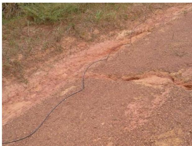
**Torção do cabo após desenrolamento inadequado**
